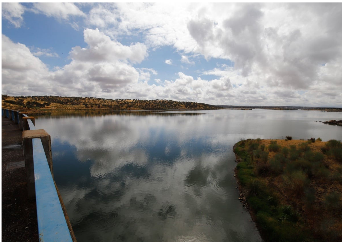
Presa del embalse de La Colada, en el término municipal de El Viso Álvaro carmona
